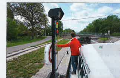
Une fois dans l'écluse, le plaisancier pousse une tige bleue pour activer le mécanisme.
