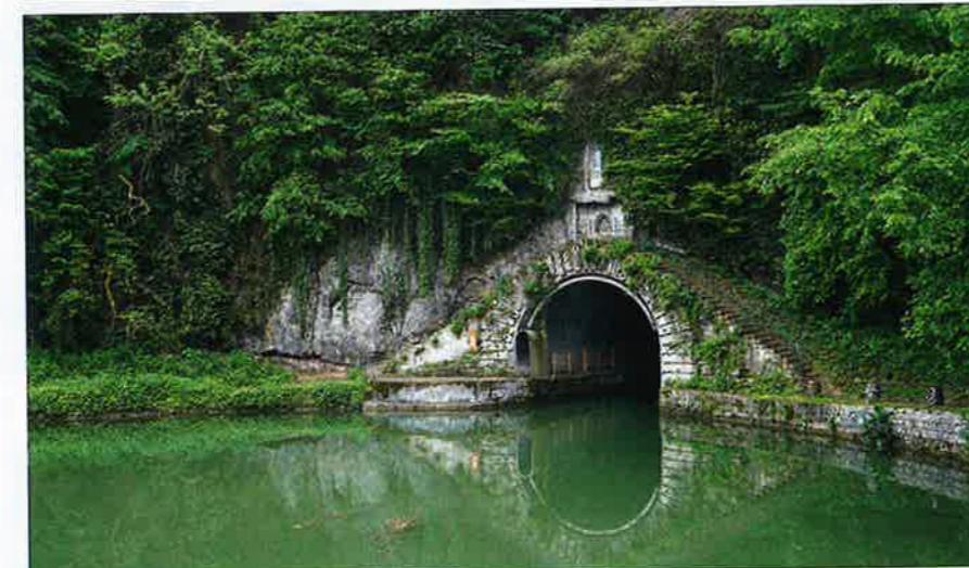
Le tunnel de Thoraise est un ouvrage d'art éclairé par des points lumineux intégrés à des tuyaux en plastique.
