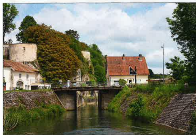
Ce pont montre l'étroitesse de certains passages, écluses comprises. L'idéal est de laisser filer le bateau sur son erre et de manœuvrer avec le propulseur d'étrave.
